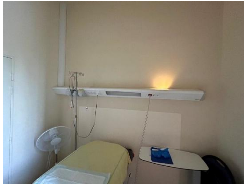
Photo d'une GTL horizontale dans une chambre du N+1
